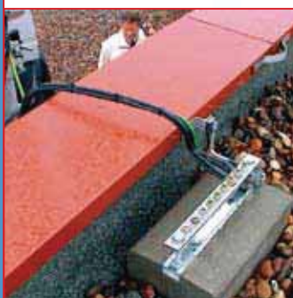
安装于屋顶的等电位连接排 Equipotential bonding at a rooftop installation
